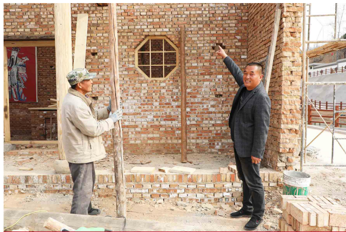
田金龙(右)在庆都庙翻修施工现场
