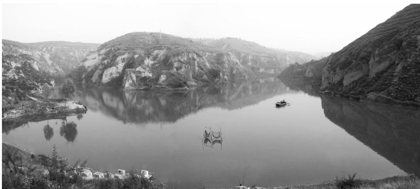
1970年10月动工、1975年竣工的绛县安峪沟水库位于安峪村东南刺权沟内，控制流域面积10.6m<sup>2</sup>，干流长6.4公里。总库容326万m<sup>3</sup>，有效库容275万m<sup>3</sup>，防洪库容34万m<sup>3</sup>，死库容15万m<sup>3</sup>，目前淤积库容25万m<sup>3</sup>，受益者包括安峪、董封、东三涧、仓丰、长杆、冯村、永乐、下柏9个村庄，可浇灌1.8万亩农田。
